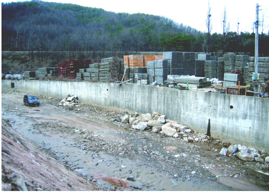
① 바이오보드 시공전(옹벽부)
