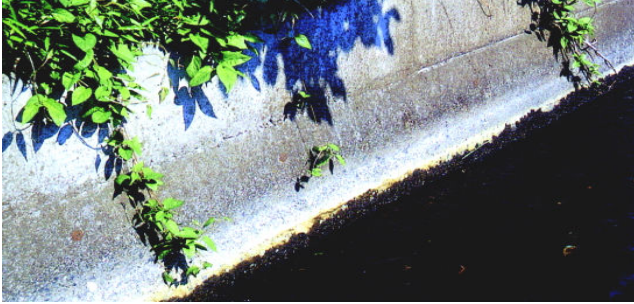
① 설치전 콘크리트 옹벽
